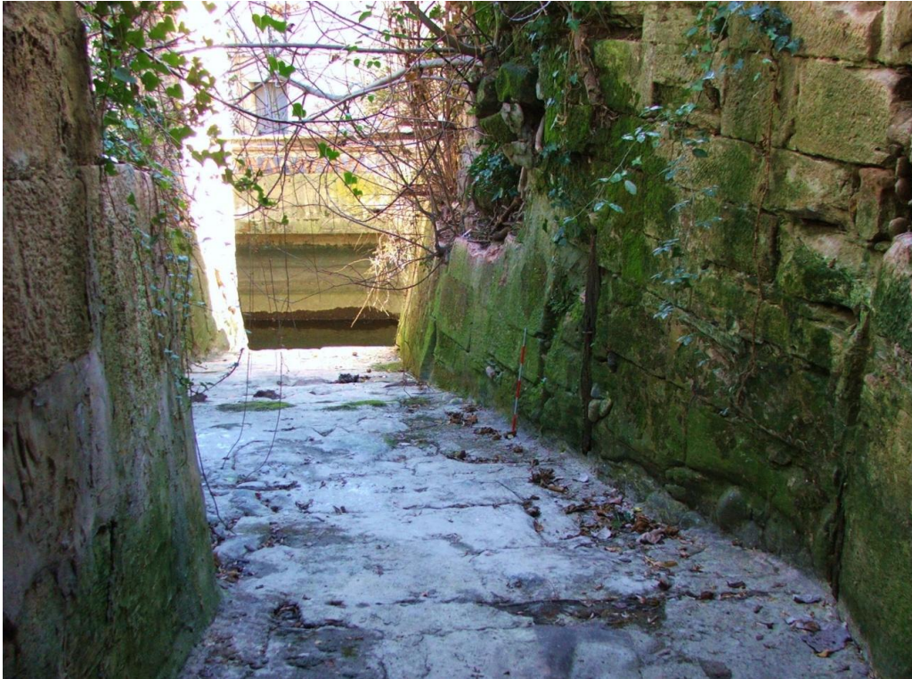
Fig.13. Ramal Sud del Canal de Pinyana, al Nord del Molí d'Alfarràs, probablement el Canal Vell documentat el 1820. S'observa l'aparell de grans carreus de l'enllosat i dels paraments. En aquests hi ha guies de fusta que es podrien correspondre amb antics estelladors. Josep Gallart.
