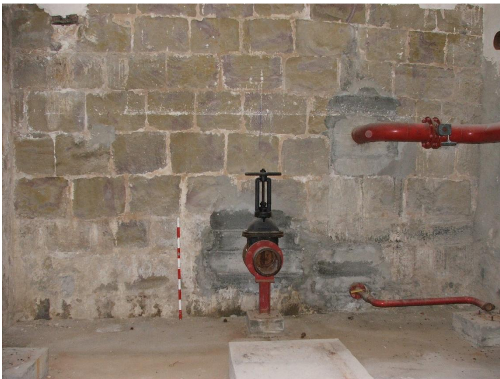
Fig. 11. Mur intern que separa el cos Nord del cos Sud a l'antiga sala de moles del Molí d'Alfarràs, vist des del cos Sud. S'observen elements contemporanis que responen al dipòsit d'aigua emplaçat a la sala de moles del cos Nord. Josep Gallart.
