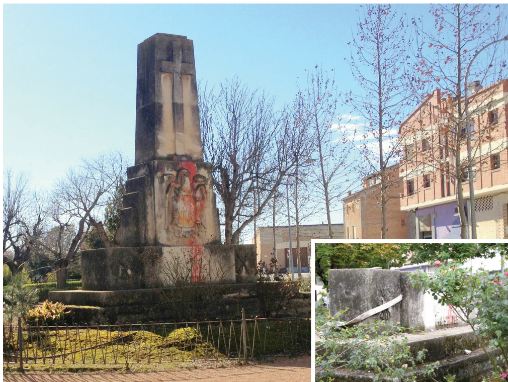
Foto 18. Monument als Caiguts de Torregrossa, abans i en el moment de la demolició, el 18 de juny del 2013. Fotografia: Servei d'Història, Documentació i Patrimoni de la UdL.
