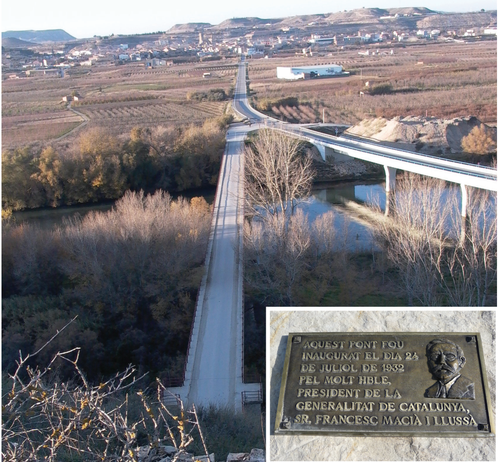
Foto 2. El vell pont de Seròs fou inaugurat pel president Macià l'any 1932. Va ser l'únic que es mantingué dempeus en aquesta zona, que romangué nou mesos sota la línia de front. Actualment, un monòlit situat a l'entrada del pont així ho commemora. Fotografia: Servei d'Història, Documentació i Patrimoni de la UdL.
