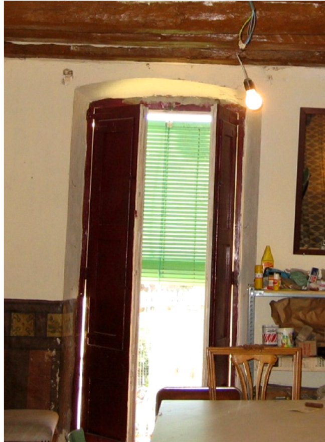
Vista interior de l'obertura on es distingeix el pla inclinat per a la captació de llum
