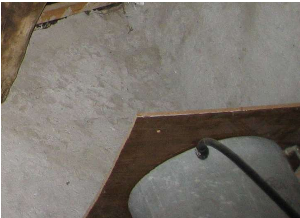
Dipòsit d'acumulació de fibrociment
