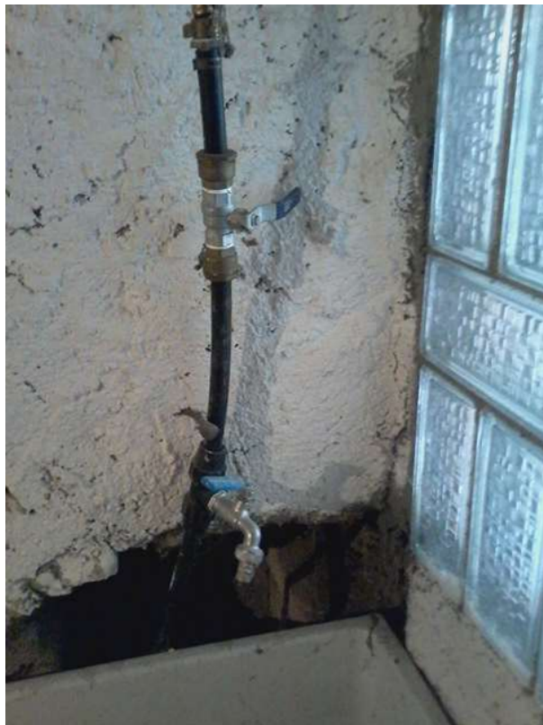
Aixeta de pas general d'esfera. Tubs vistos de PVC
