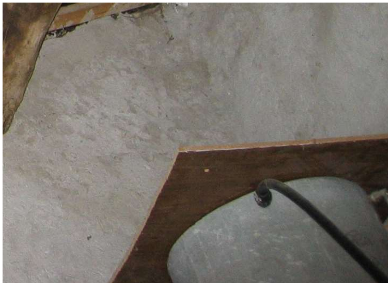
Dipòsit d'aigua de fibrociment
