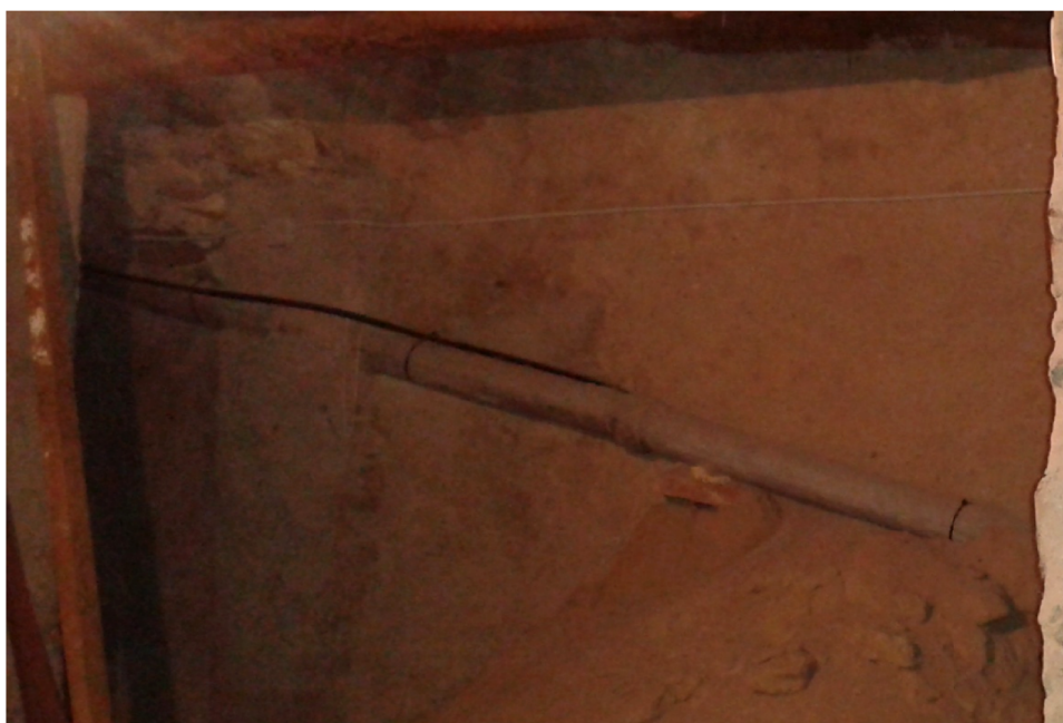
Col·lector vist de fibrociment
