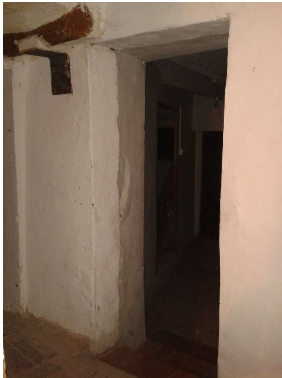
Mur de càrrega
