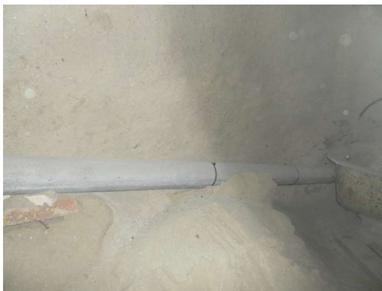
Col·lectors vistos de fibrociment
