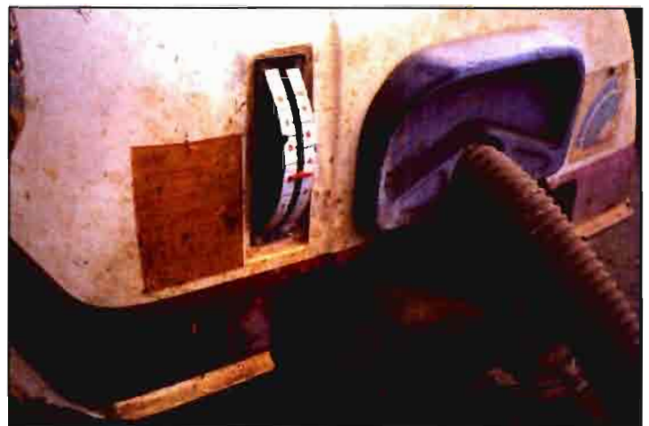
Inspección del funcionamiento de Indicador de nivel.
