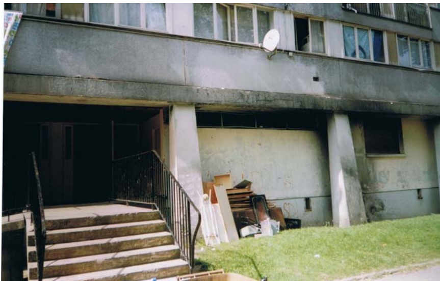
Fig. 6. Portal de edificio residencial en Clichy-sous-Bois. Fuente: fotografía del autor.
