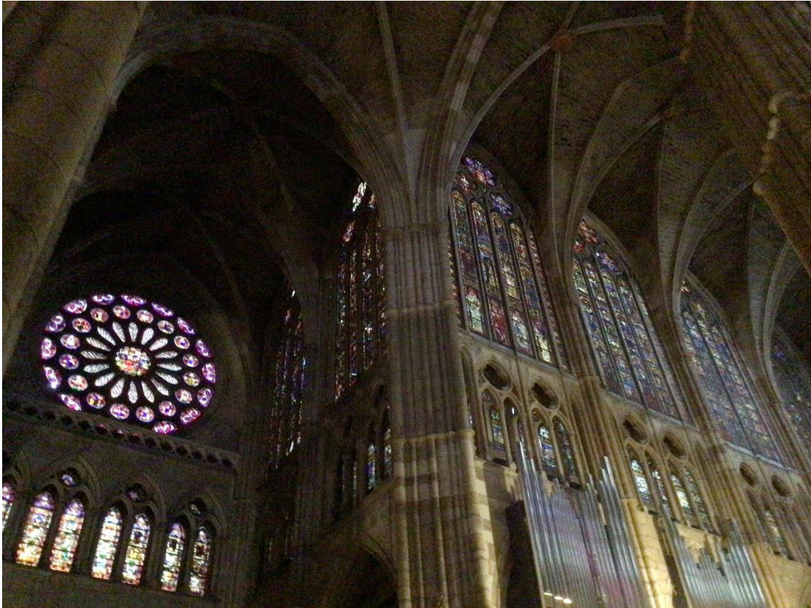
Figura 15: Catedral de León. Triforio y claristorio de la nave central y el crucero. Foto del autor.
