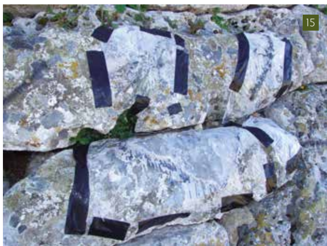
[15] Detall d'un dels grafitis durant el procés de remoció. Es pot observar el gel aplicat i cobert amb film de polietilè (Fotografia: Francesc Isbert).
