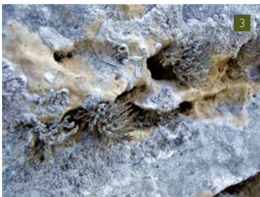
[3] Imatge de detall del recobriments biològic que afecta de manera generalitzada la pedra (Fotografia: Francesc Isbert).
