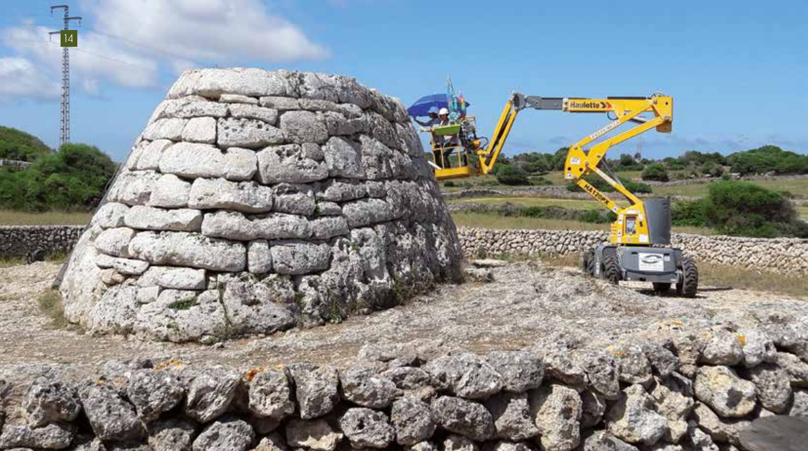
[14] Imatge durant els treballs de restauració en alçada amb màquina elevadora (Fotografia: Francesc Isbert).
