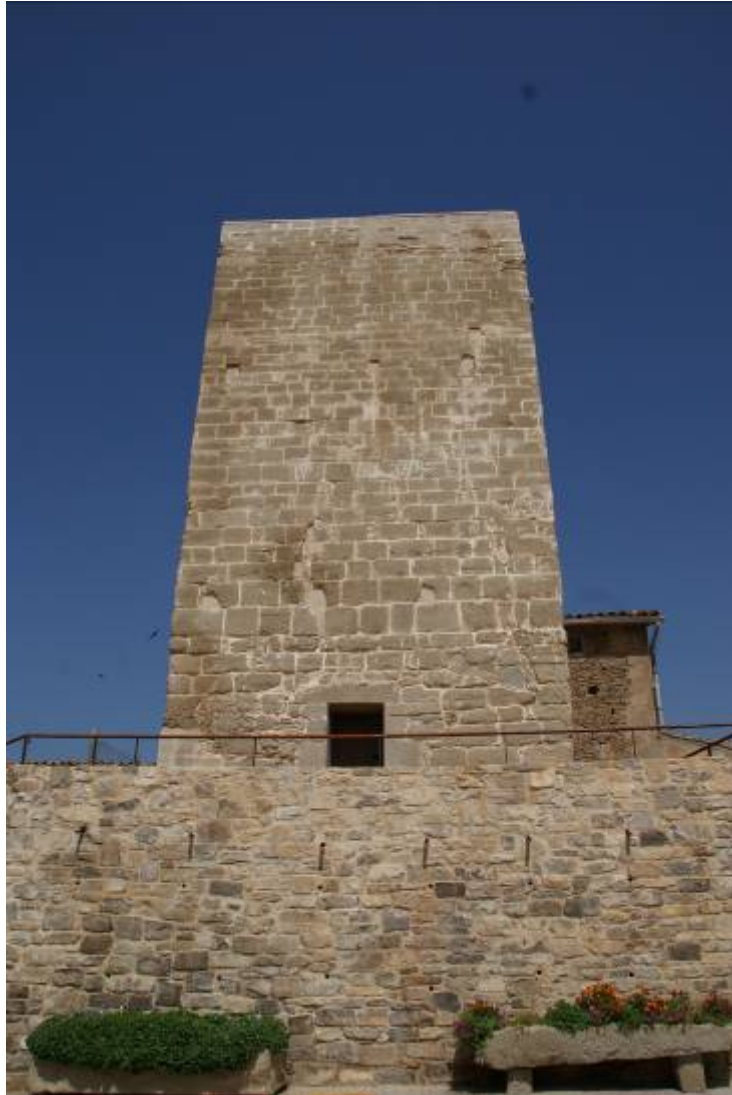
Torre de la Guàrdia d'Urgell. Carreu de pedra a llarg i través irregular.
