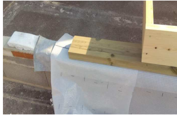
Figura 2. Arranque sobre murete y protecciones
