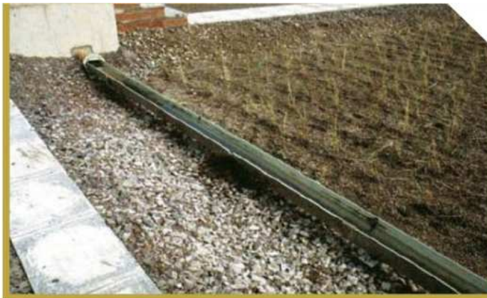
Entrada con canaleta (Cooper et al., 1996) FOTO 3
