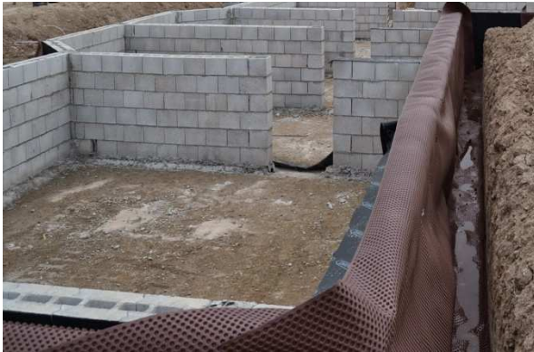
Figura 2. Arranque sobre murete y protecciones
