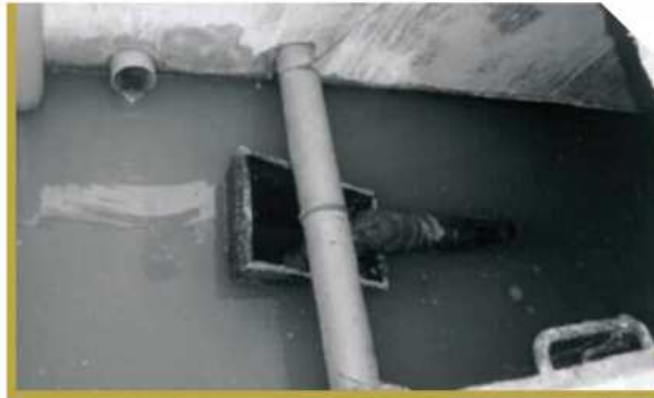
Tanque de alimentación y mecanismo – Nivel óptimo de agua en el tanque para llenar el cubo (Shrestha, R.R., 1999)
