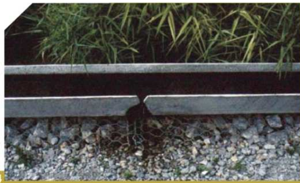
Entrada con canaleta - primer plano (Cooper et al., 1996) FOTO 4
