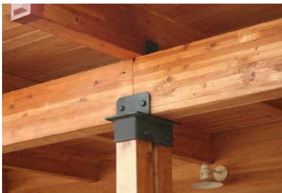
Figura 11. 3D e imágenes tipo de de encuentros de pilares vigas y viguetas
