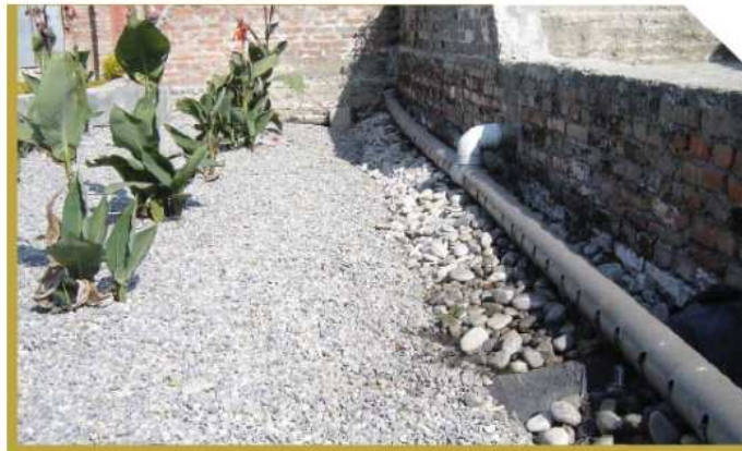
Entrada con tubería perforada FOTO 1
