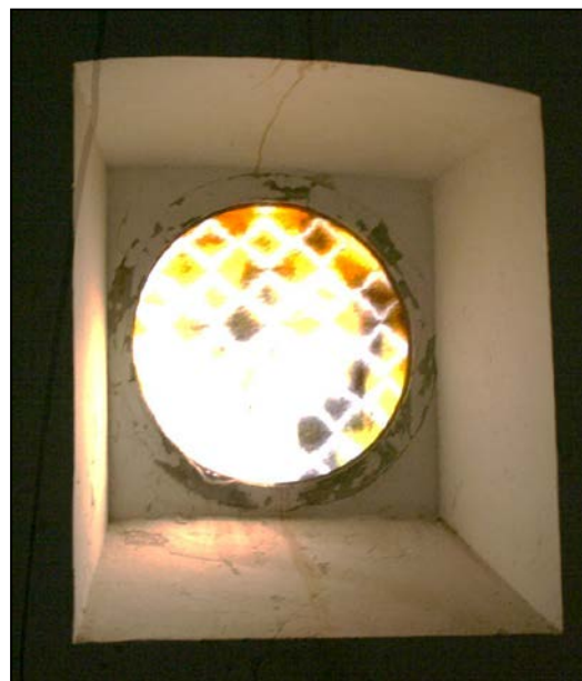
46. Imatge de la fusteria vidriada existent
