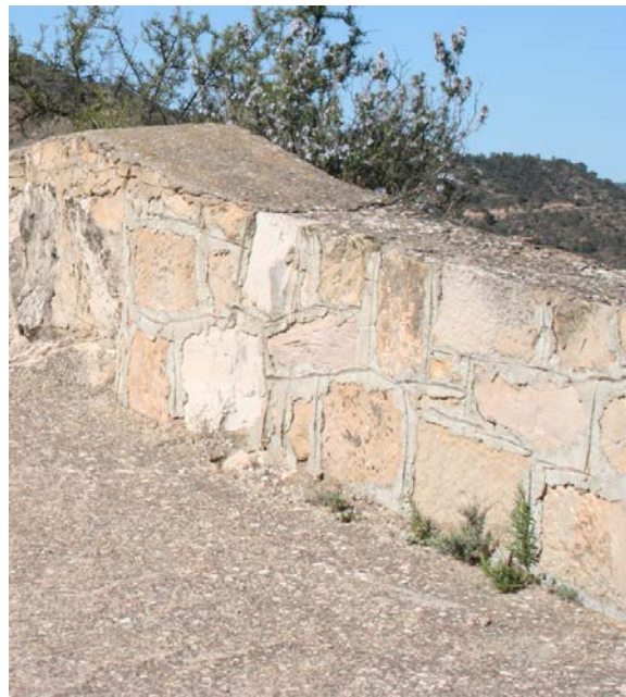
56. Fotografia del mur de maçoneria. Actuació I
