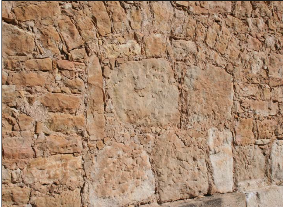
43. Imatge de la paret lateral actual
