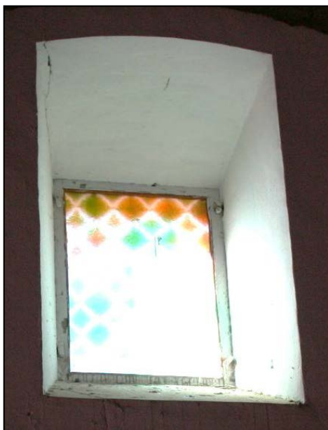
45. Imatge de la fusteria vidriada existent
