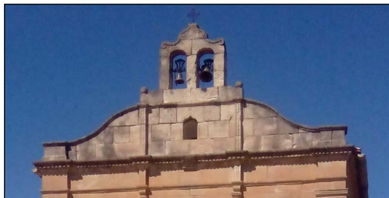
10. Imatge. Coronament de la façana
