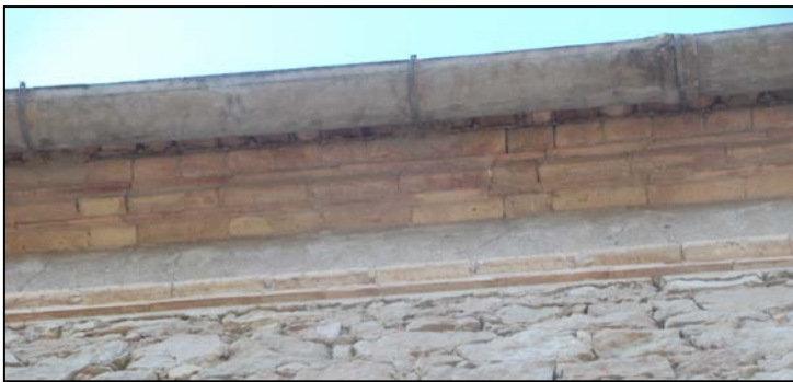
47. Imatge del canaló de fibrociment
