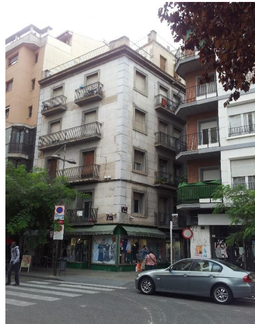
Il·lustració 26: Edifici estudiat vist des de l'avinguda Blondel
