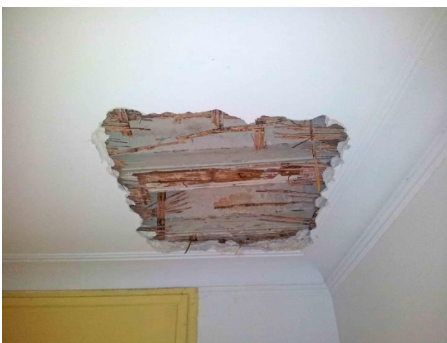
Il·lustració 33: Imatges dels forjats de l'edifici
