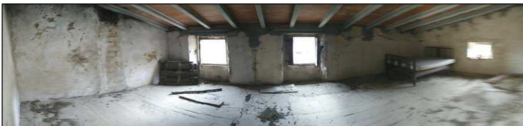
Panoràmica estança 6, amb coberta de bigues de formigó.
