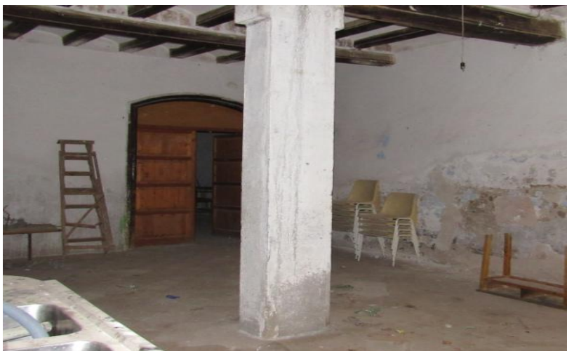
'Fig 3.13. Pilar de formigó a l'entrada principal.'
