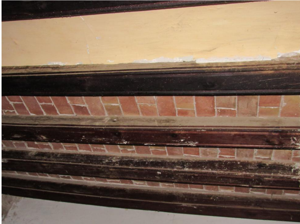
'Fig 3.15. Estructura horitzontal. Entrebogat reformat a partir d'obra ceràmica.
