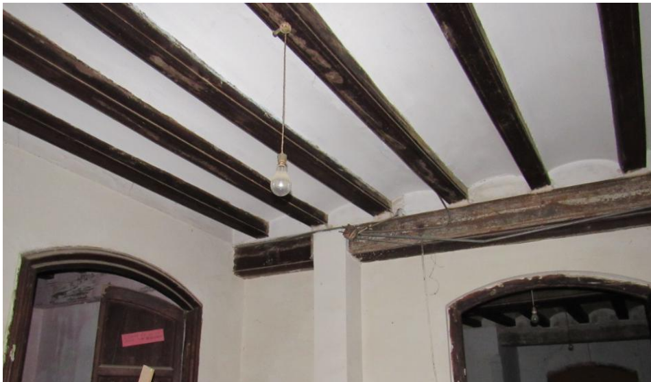
'Fig 3.14. Estructura horitzontal formada per bigues de fusta i revoltó ceràmic.'
