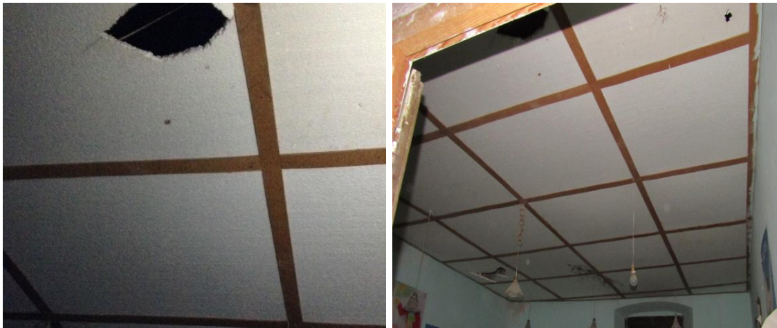
Imatge dels falsos sostres propis del 1900.
