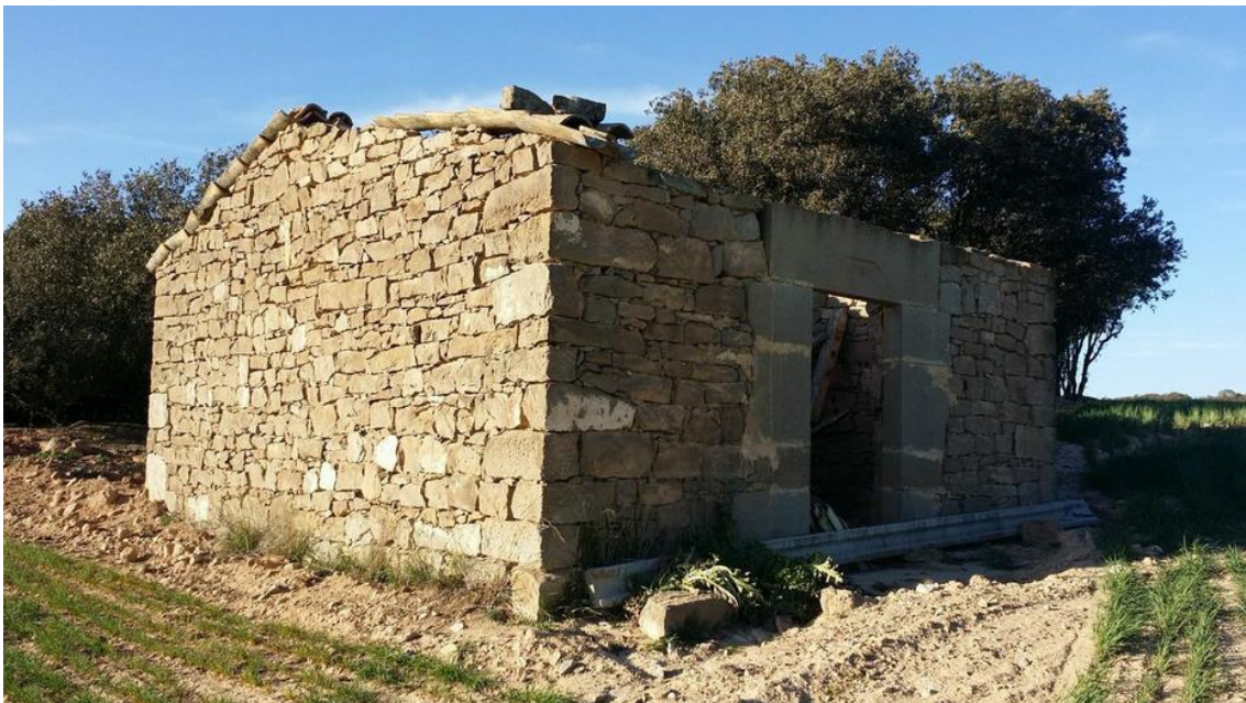
Fig.21.1 Vista zona frontal i lateral esquerra
