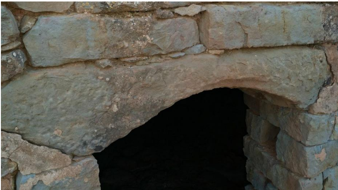
Fig.6.2 Llinda amb forma d'arc
