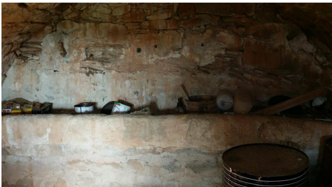
Fig.3.2 Menjadora de pedra al llarg de tot el fons de la cabana
