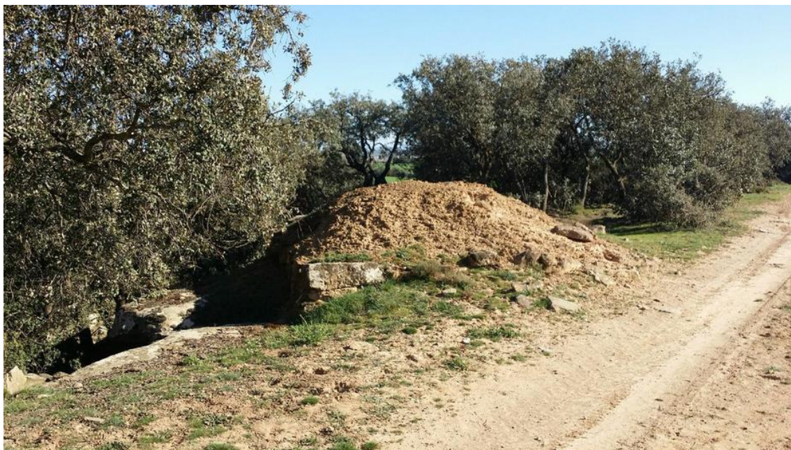
Fig.19.1 Coberta i camí (manca de vegetació a la coberta)
