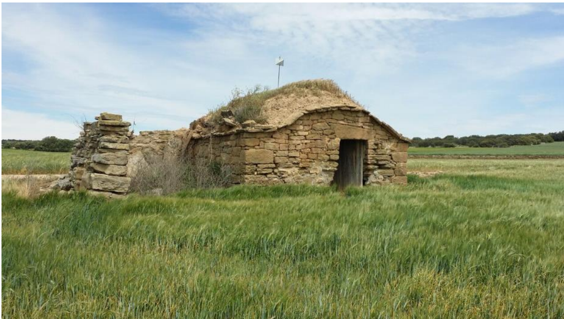
Fig.31.1 Vista exterior del conjunt
