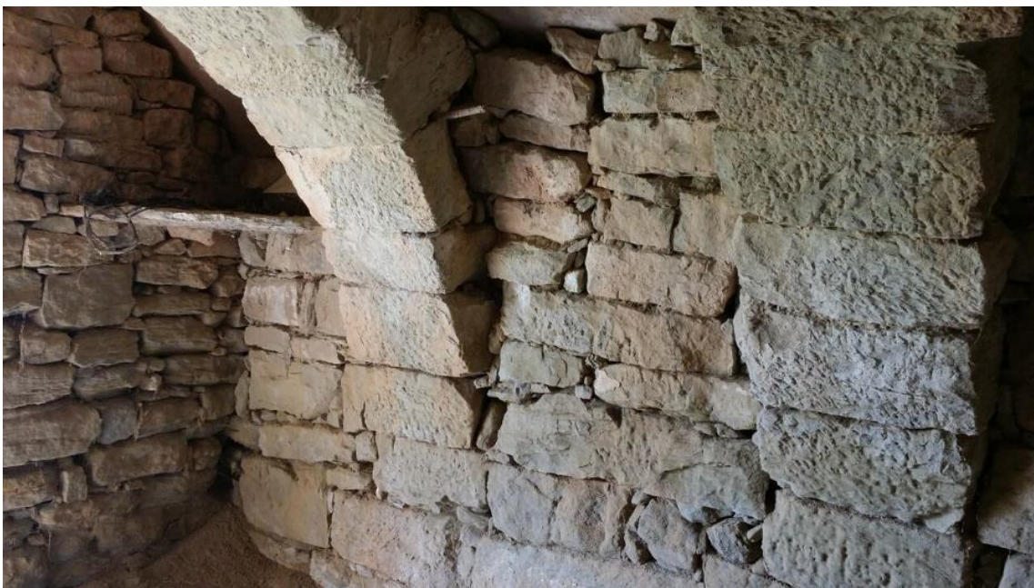
Fig.31.4 Vista interior dels arcs i prestatge amb llosa
