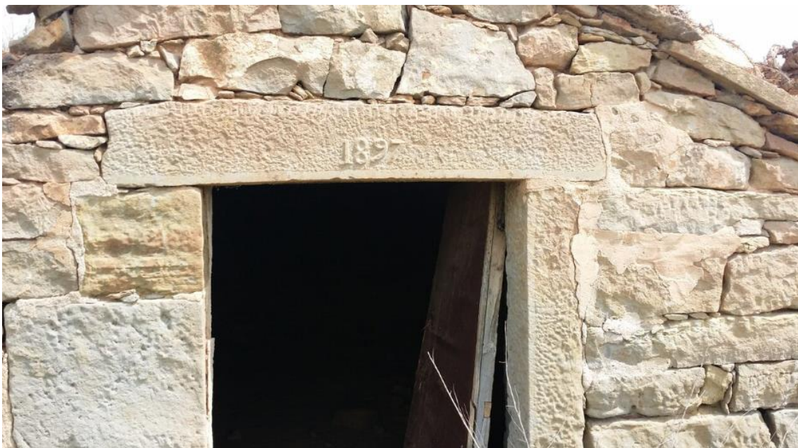
Fig.29.4 Llinda amb l'any elaborada amb pedra picada
