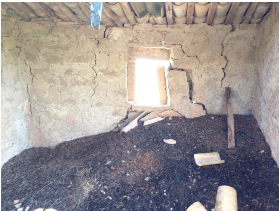
Fig.1.4 Interior planta 1a
