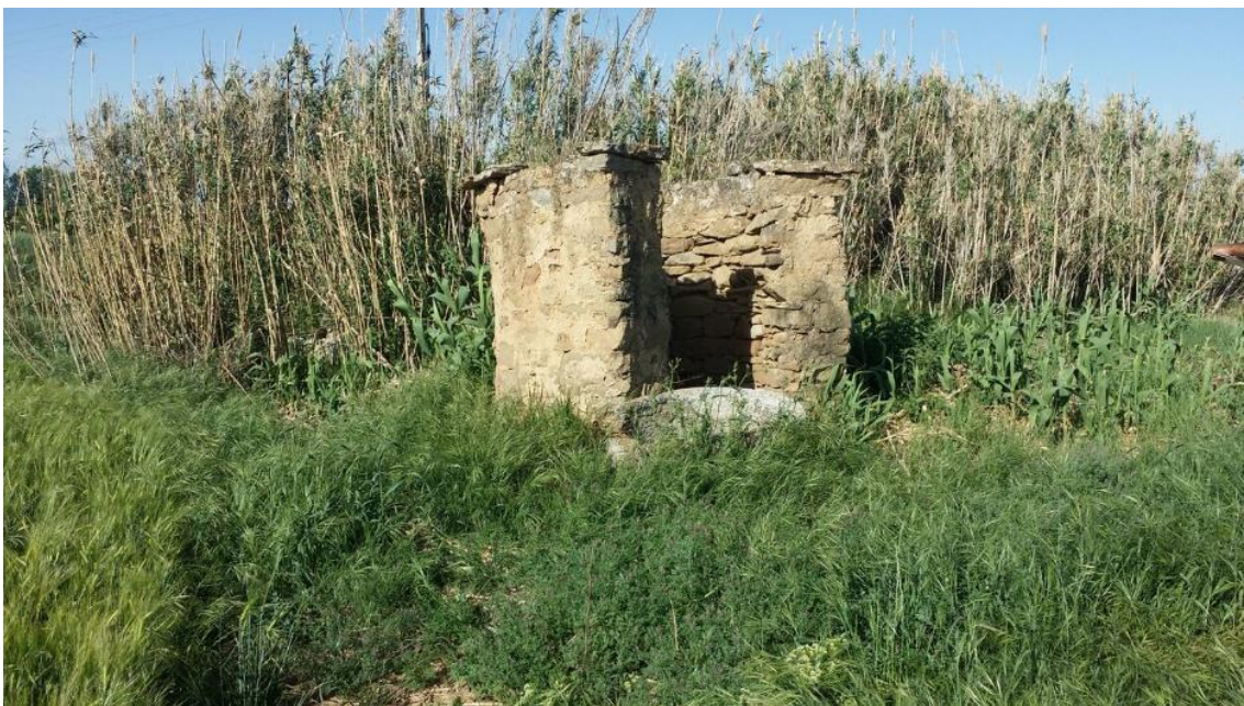
Fig.58.2 Vista frontal dreta
