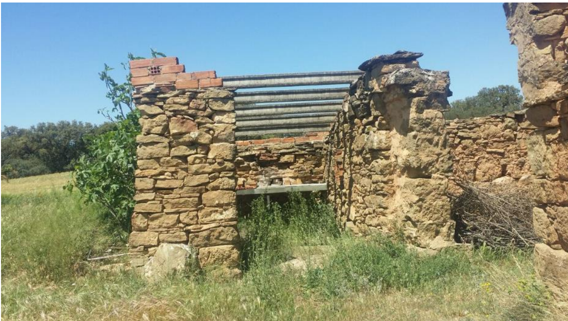
Fig.45.4 Cabana amb biguetes de formigó emparedades amb maó foradat.
