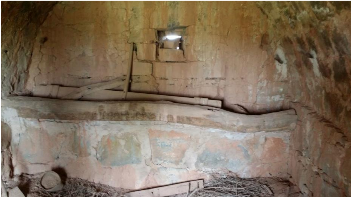
Fig.35.3 Menjadora de pedra i tronc rústec
