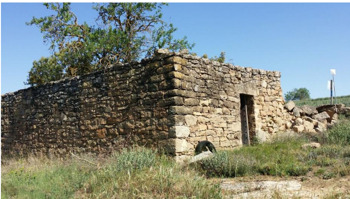
Fig.39.2 Murs lateral esquerra en perfecte estat
