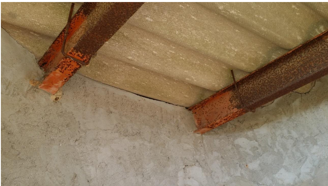
Fig.67.2 Coberta amb biguetes de ferro amb placa de fibrociment
