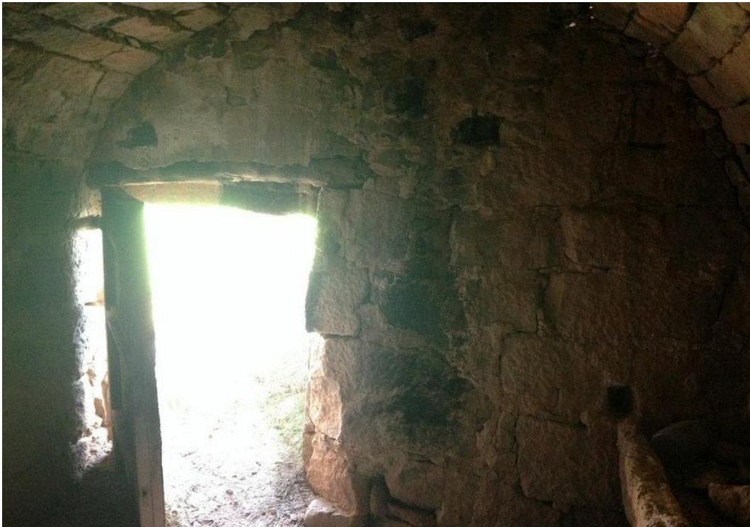
Fig.2.4 Llinda de fusta per la part posterior del peto de façana
