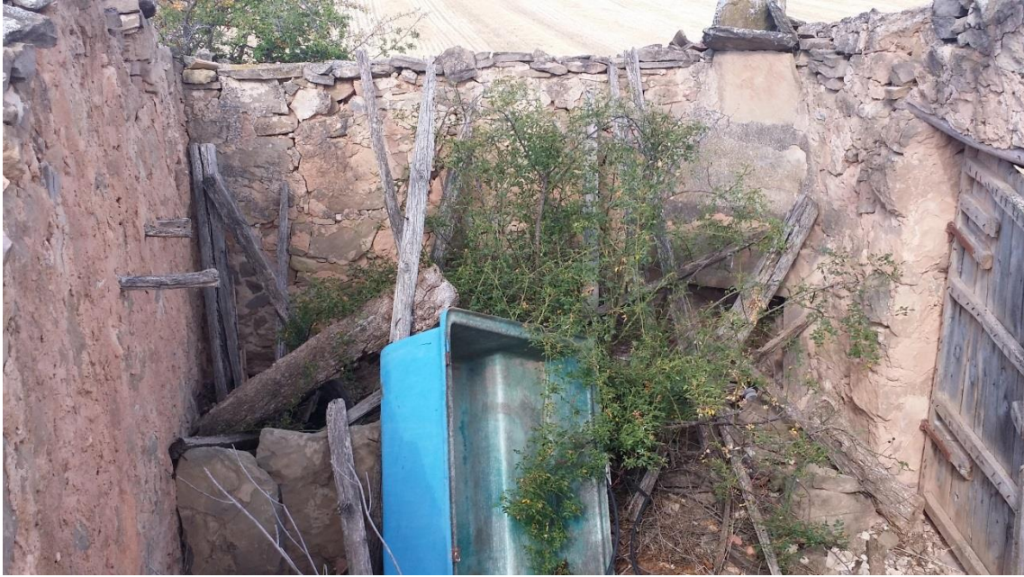
Fig.69.3 Vista interior ( foc a terra)
