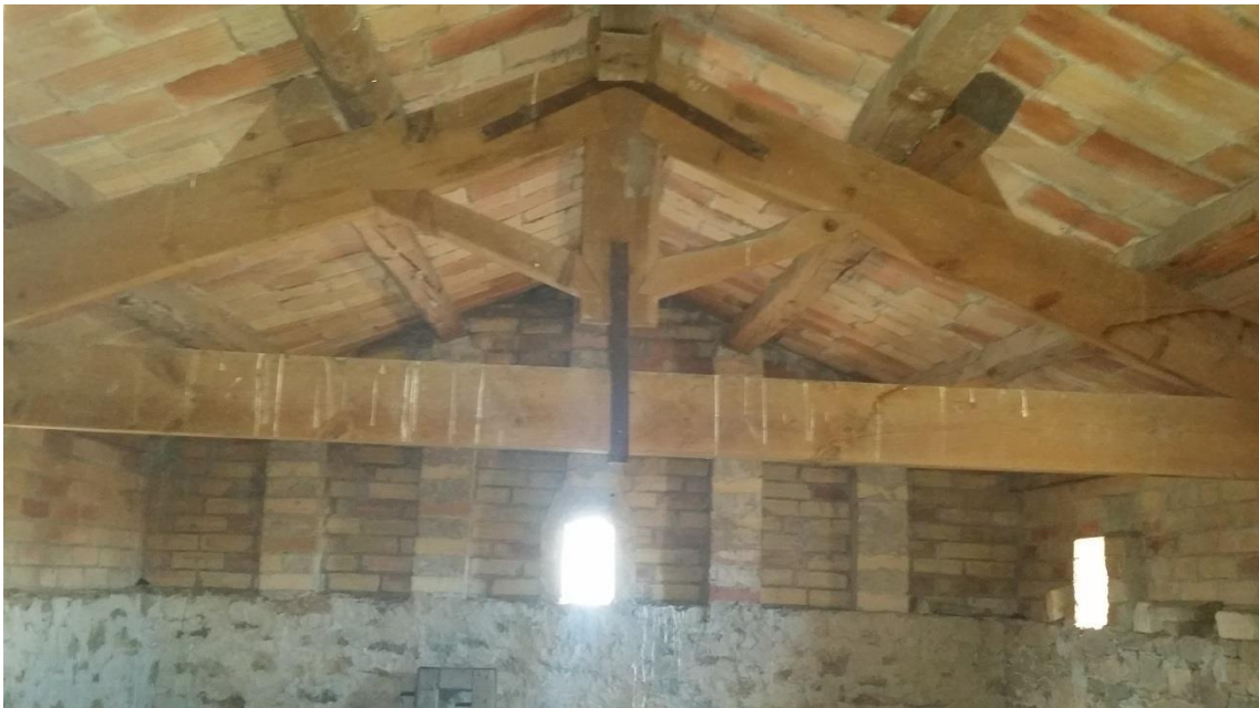
Fig.68.4 Encavallada de fusta
