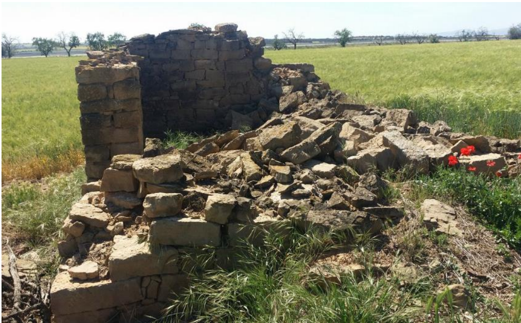
Fig.48.4 Mur lateral esquerra enderrocant
