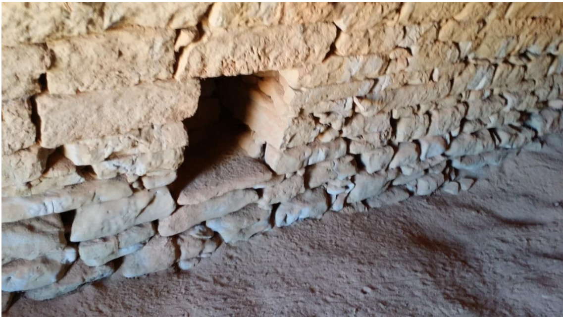
Fig.61.4 Armariet encastat al mur
