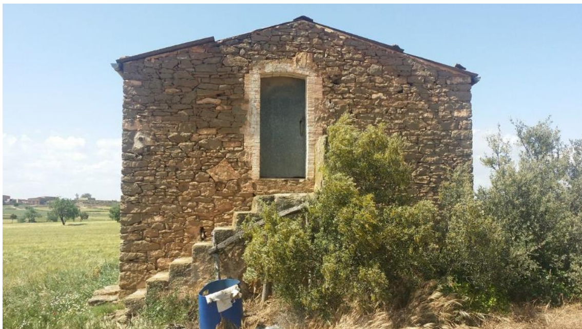
Fig.53.1 Façana lateral dreta
