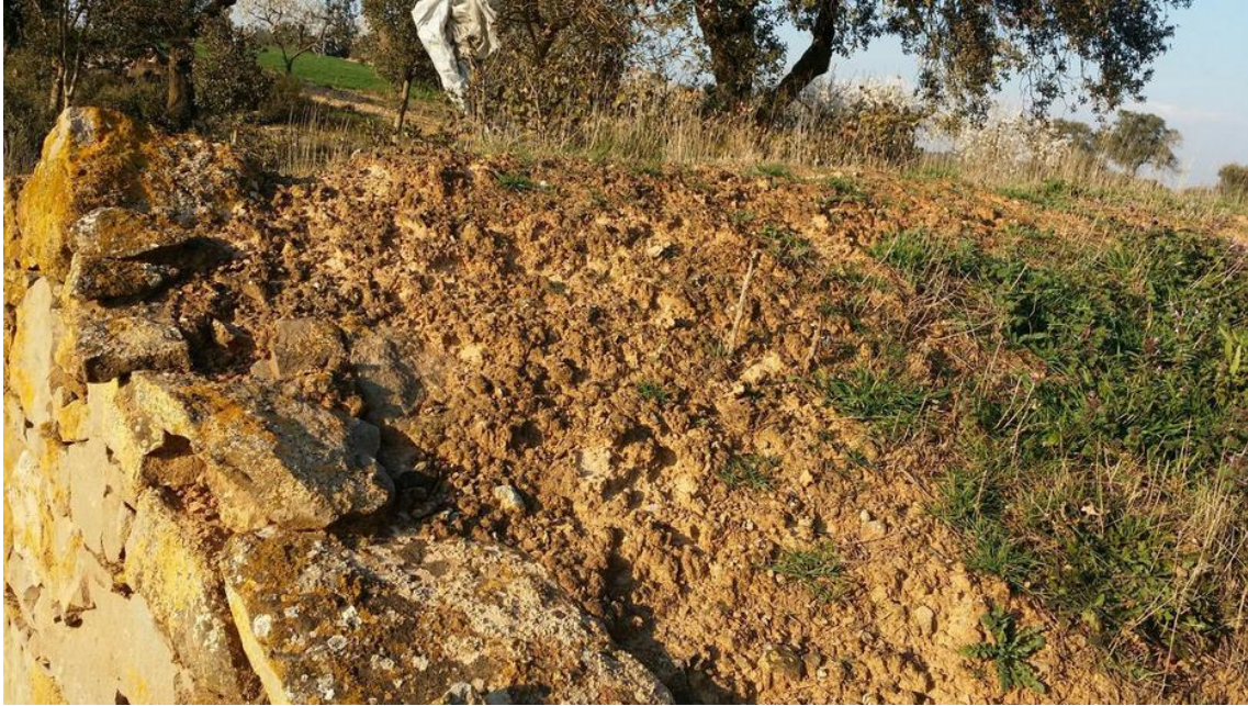
Fig.3.3 Coronament de la façana i coberta
