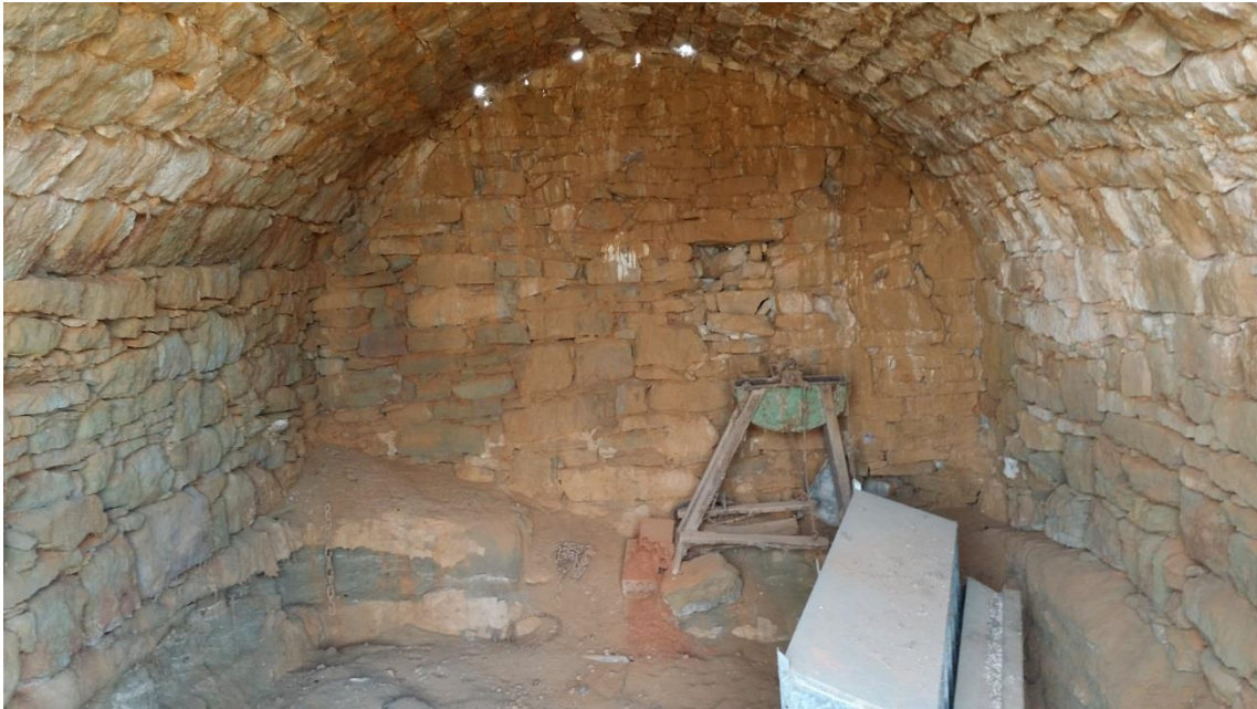
Fig.24.3 Vista interior (s'aprecien els forats)
