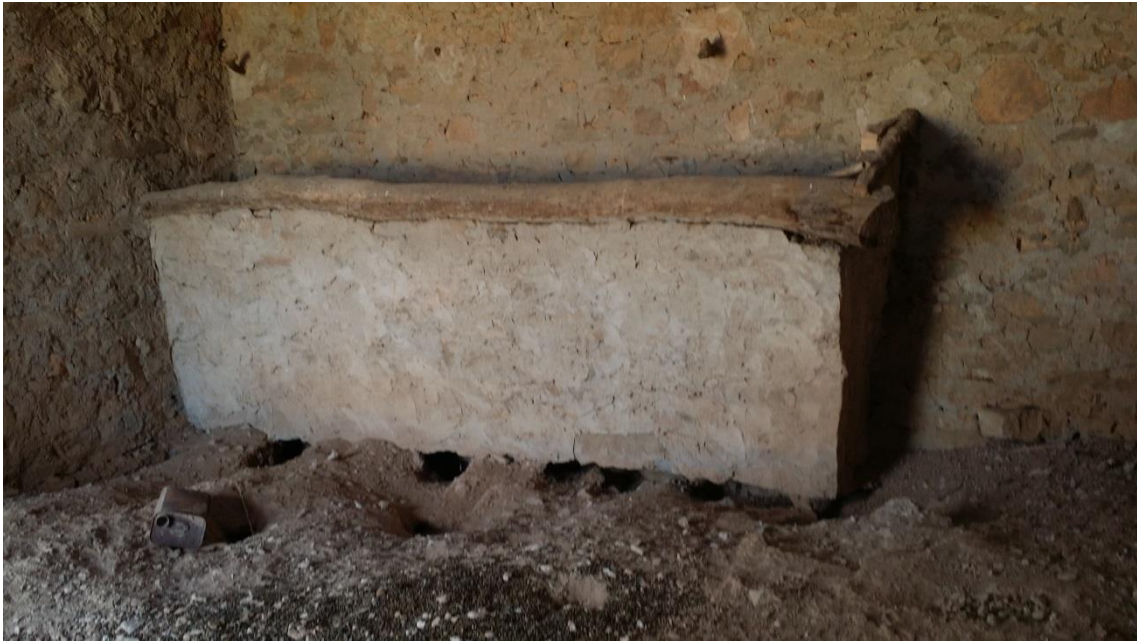
Fig.70.3 Menjadora de pedra arrebossada amb tronc d'arbre
