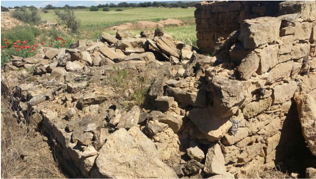
Fig.48.3 Mur dorsal enderrocant
