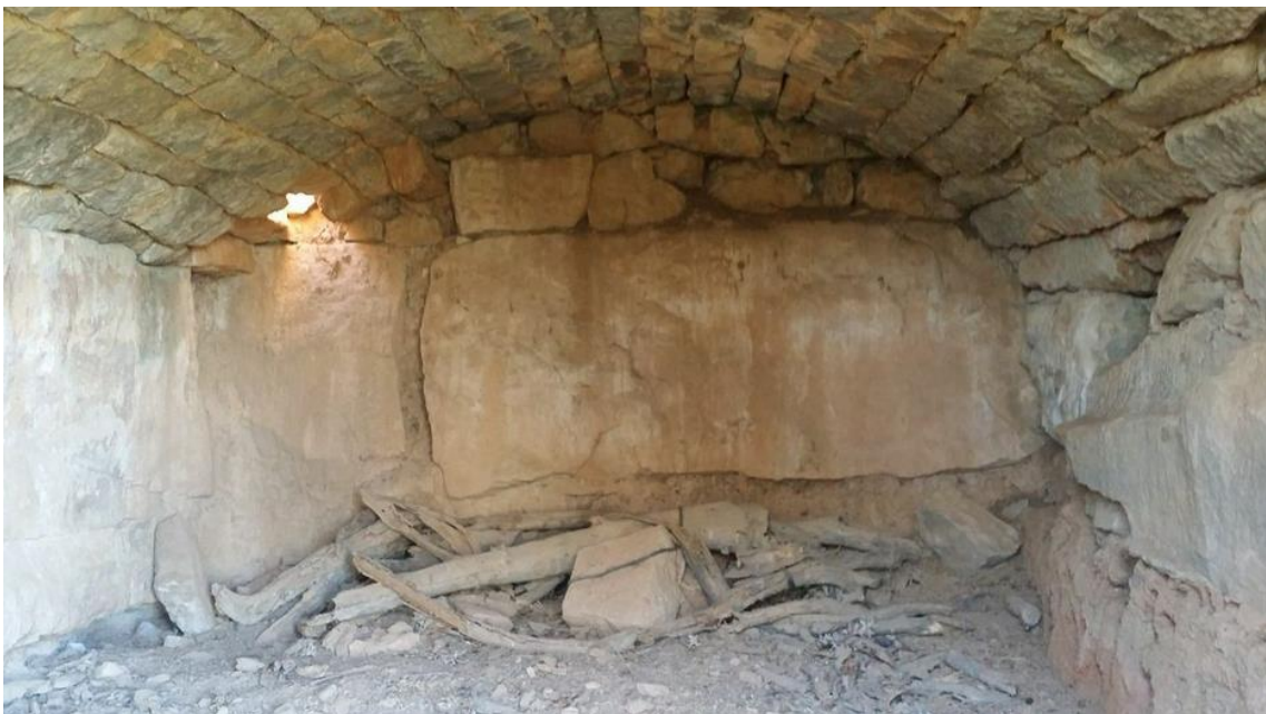
Fig.19.4 Vista interior (volta descarregant a la cinglera)
