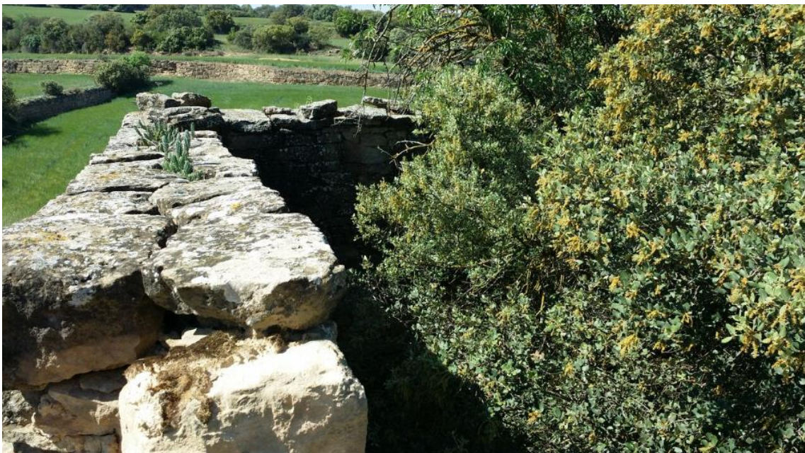
Fig.39.4 Detall de la part superior del mur
