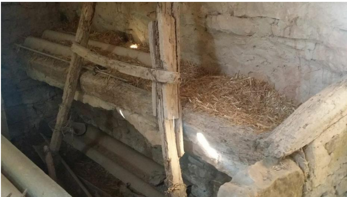
Fig.15.4 Menjadora feta amb lloses de pedra i troncs d'arbre
