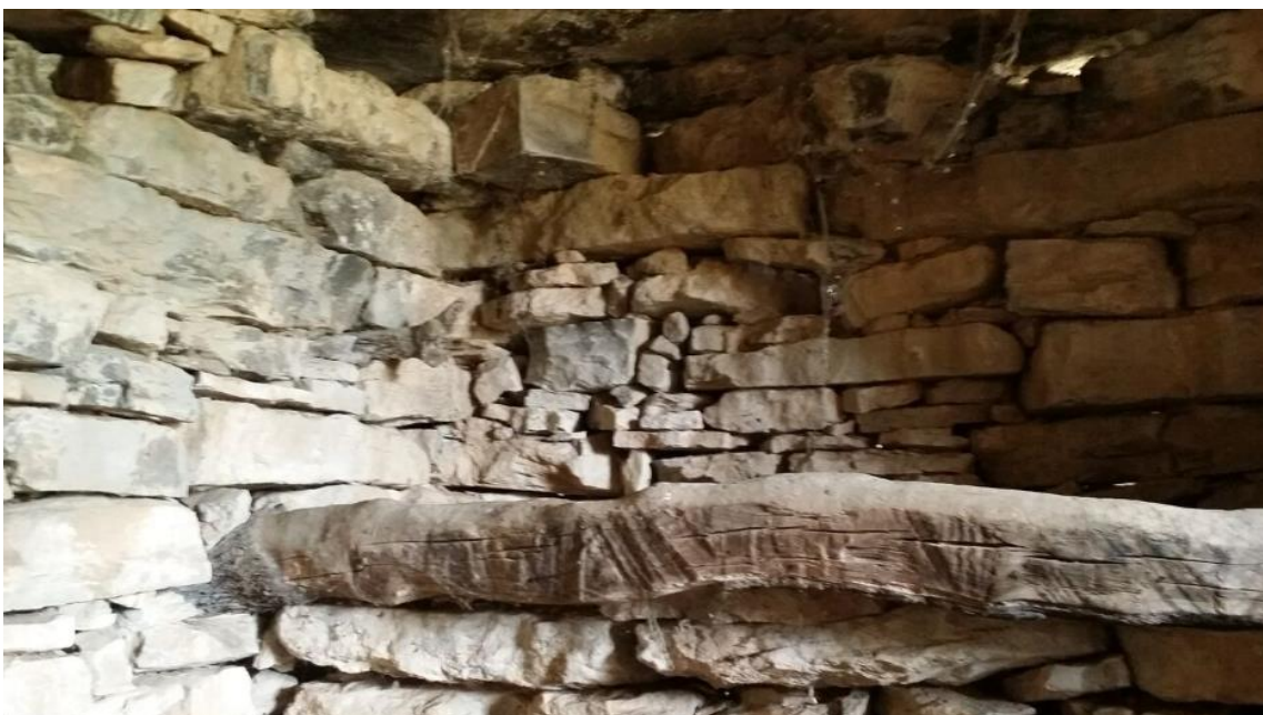
Fig.37.4 Menjadora encastada al mur lateral
