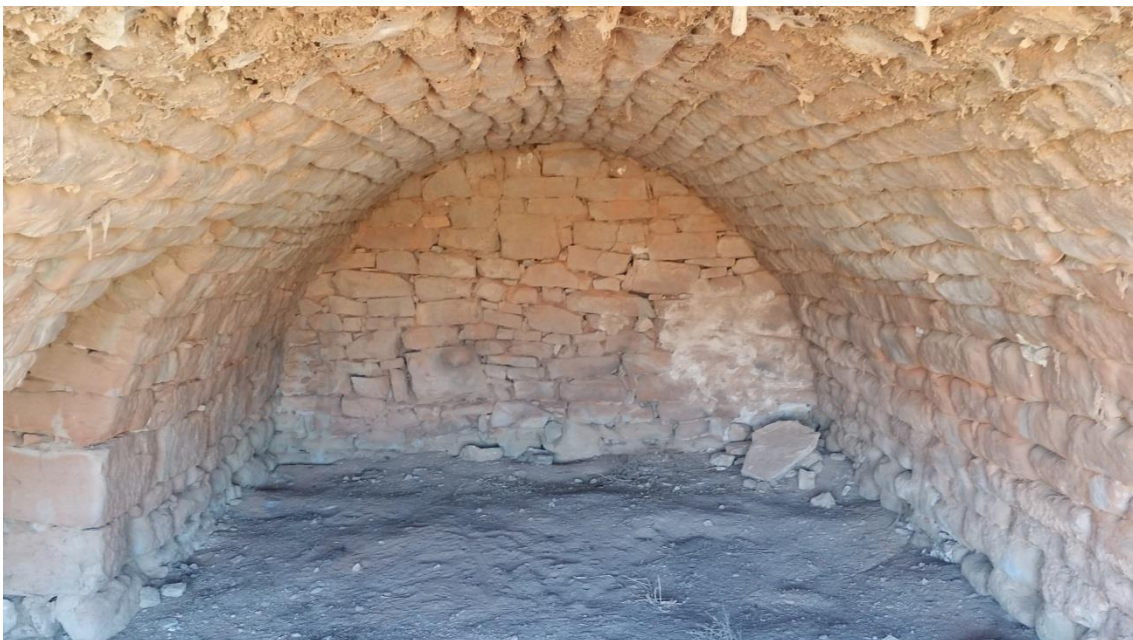
Fig.61.2 Vista interior volta
