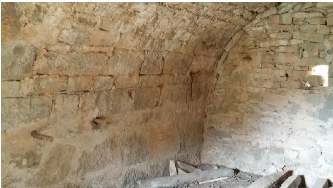
Fig.36.4 Vista interior volta
