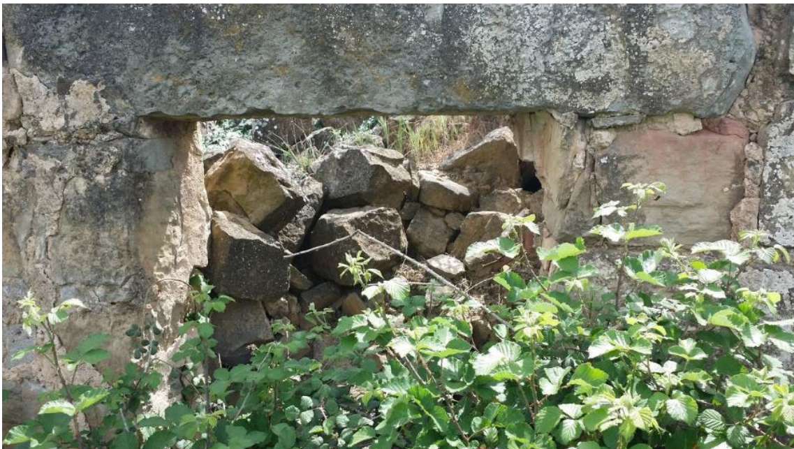
Fig.34.2 Llinda de pedra
