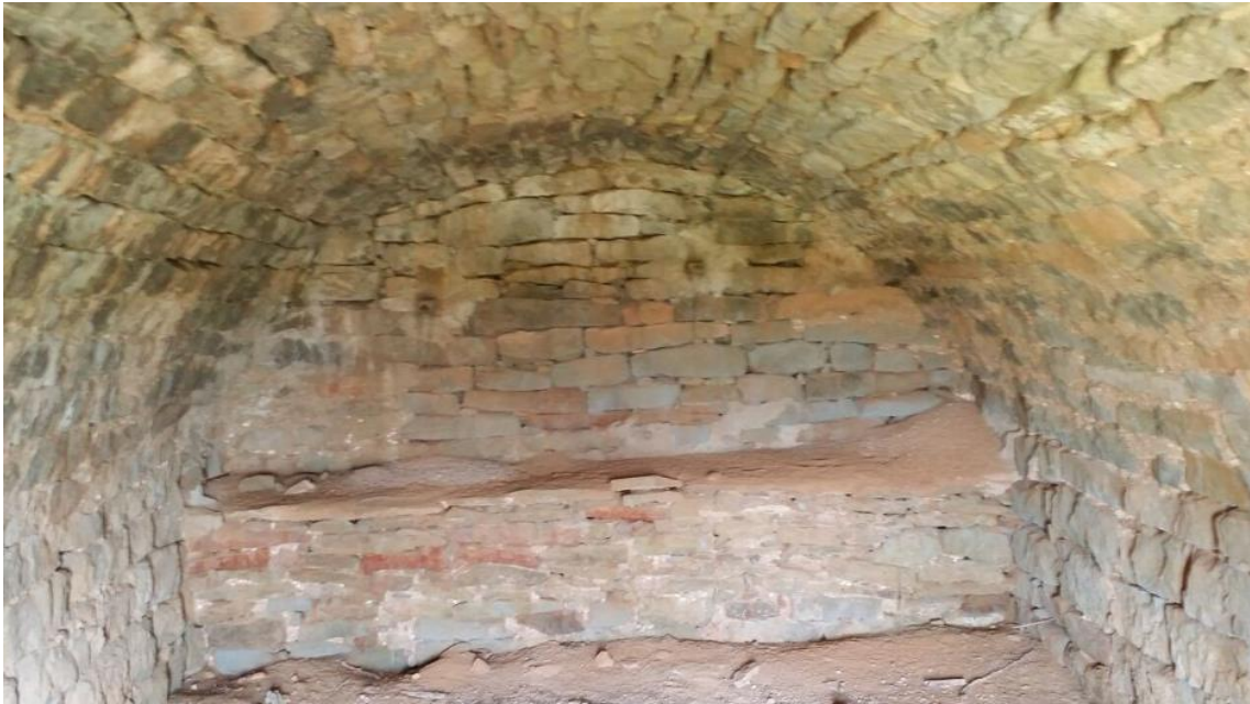
Fig.29.3 Vista interior , volta en perfecte estat
