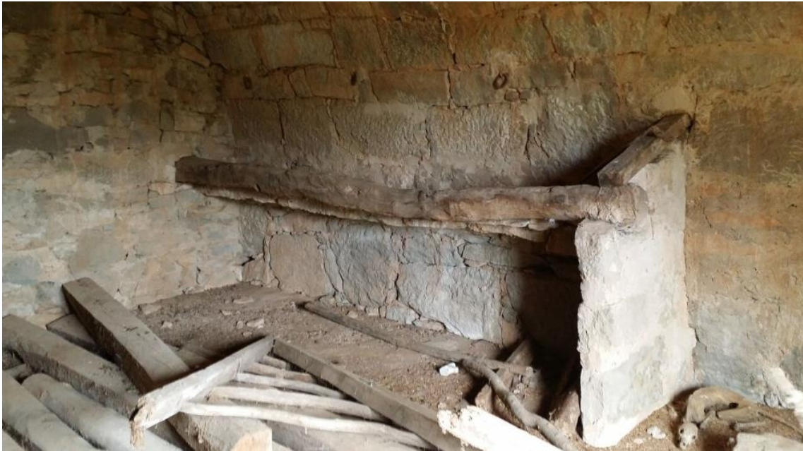
Fig.36.3 Menjadora de lloses i tronc d'arbre
