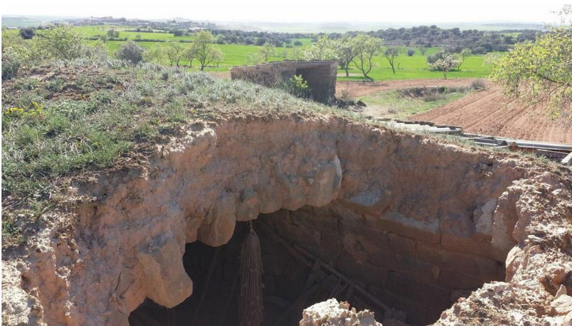
Fig.17.2 Part posterior de la coberta mig ensorrada
