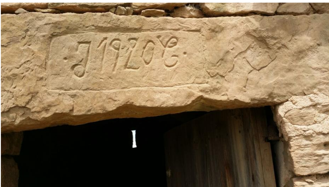
Fig.31.2 Llinda amb any de construcció
