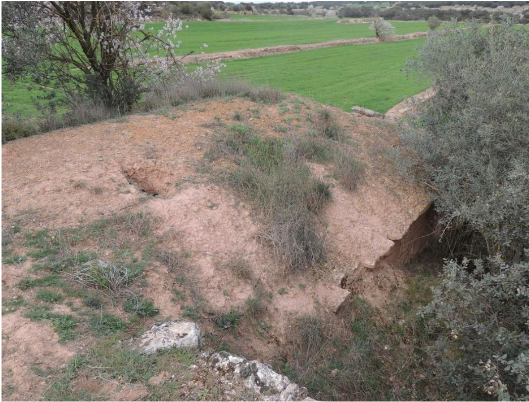
Fig.8.3 Imatge de la coberta
