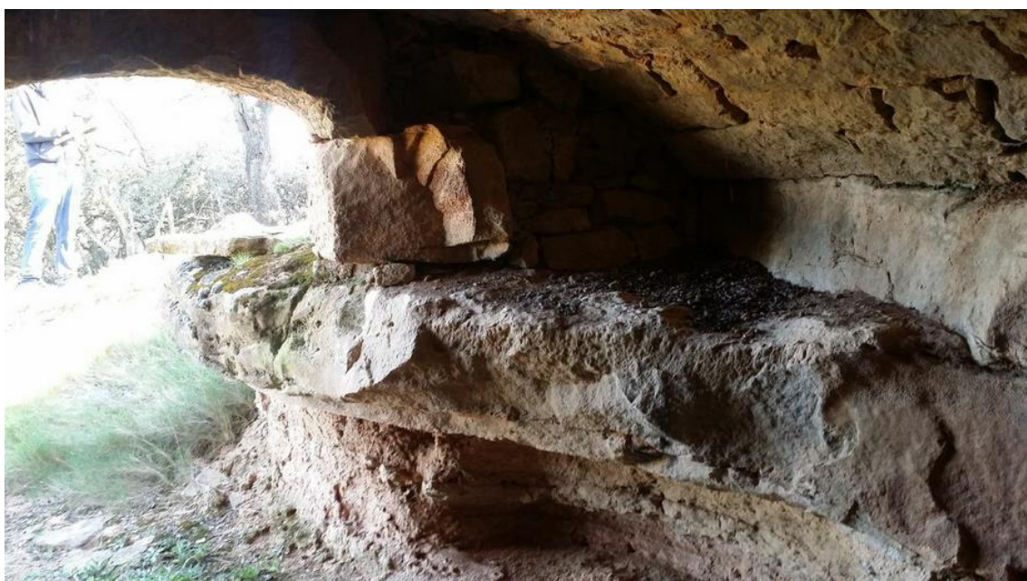
Fig.19.2 Llinda en forma d'arc descarrega al element natural
