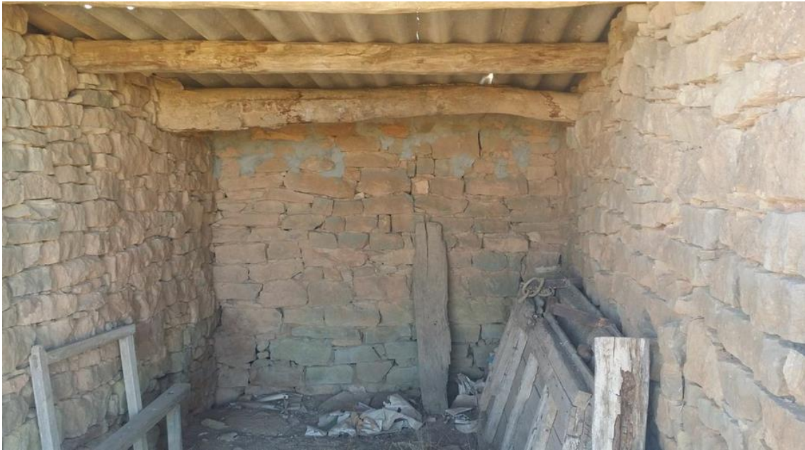
Fig.16.3 Vista interior del cobert
