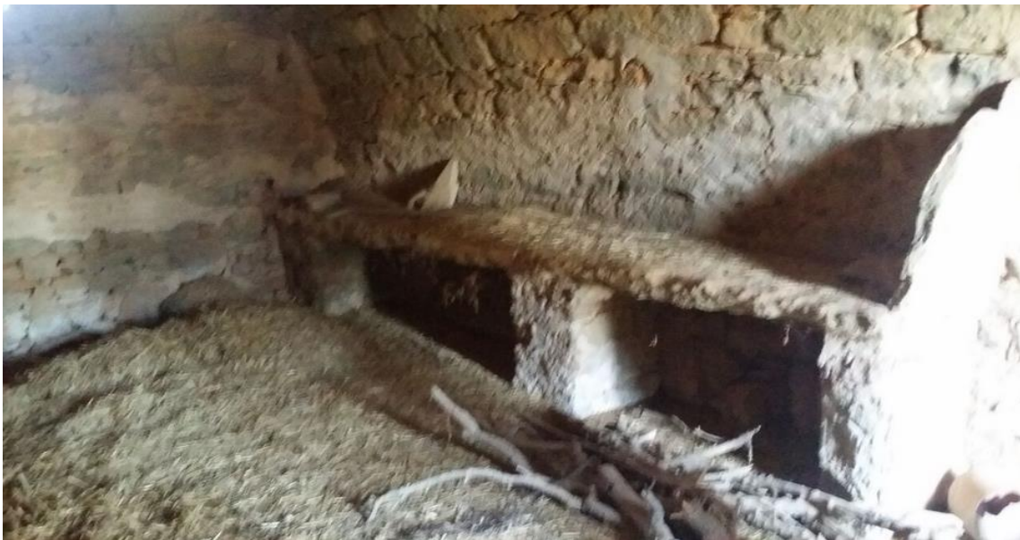
Fig.52.4 Menjadora de lloses amb tres recolzes
