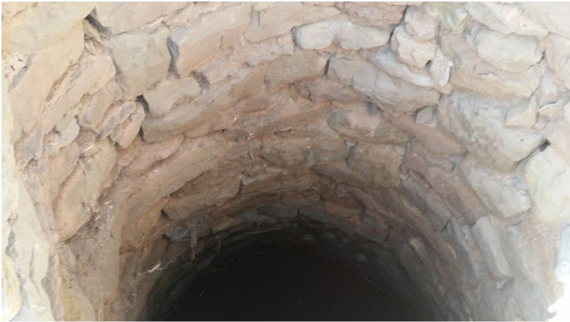
Fig.58.3 Vista interior pou (s'aprecia l'aigua)
