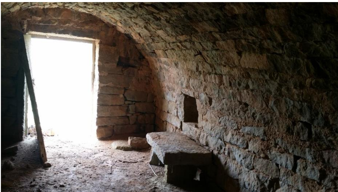
Fig.29.2 Vista interior del banquet i porta
