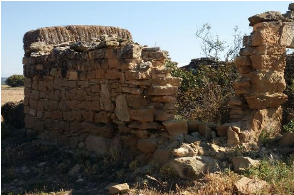
Fig.38.4 Cantonada col·lapsada
