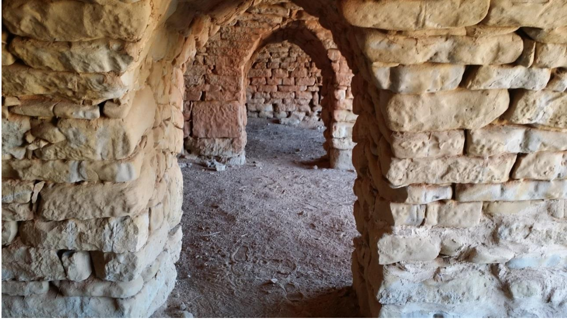
Fig.61.3 Pas interior entre les voltes vistes
