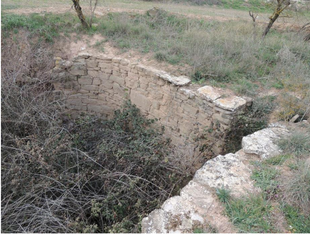
Fig.7.3 Bassa de pedra seca de grans dimensions
