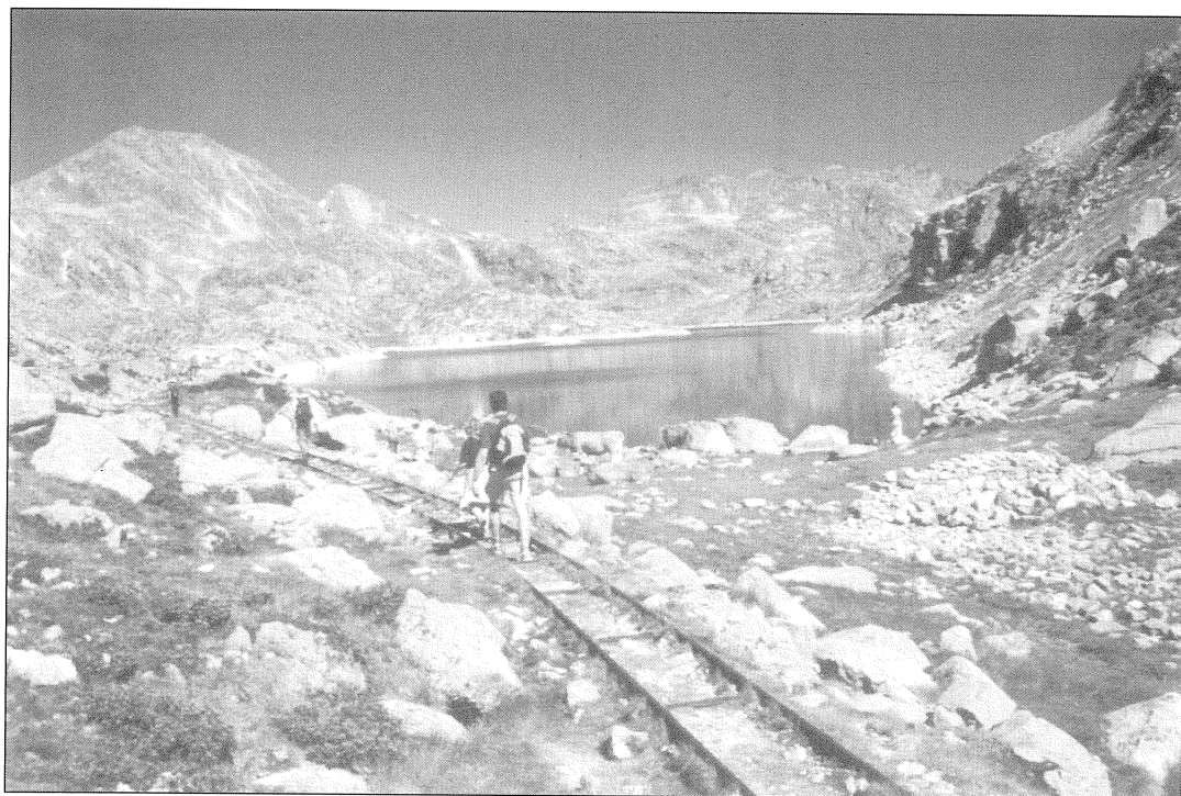
Restes de vies dels carrilets emprats en la construcció del sistema de connexió dels estanys de la capçalera del Flamisell, a l'estany Tort.
