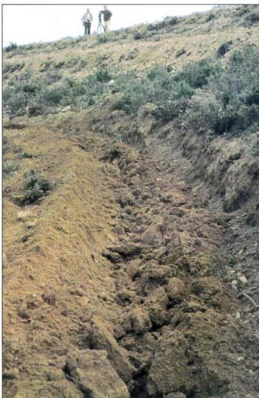
Foto 3.- En las preparaciones lineales debe controlarse la profundidad de la labor, así como la altura del caballón y sus pendientes longitudinal y transversales
