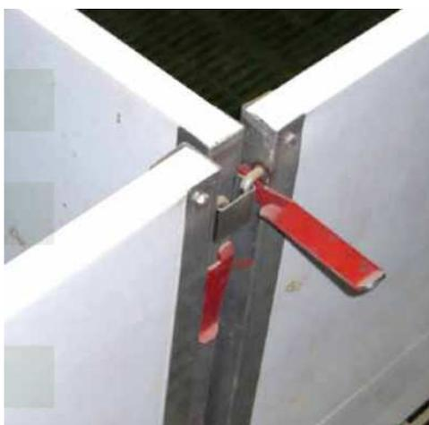
**Imagen 38. Separadores de PVC, anclajes y postes de acero inoxidable.**
