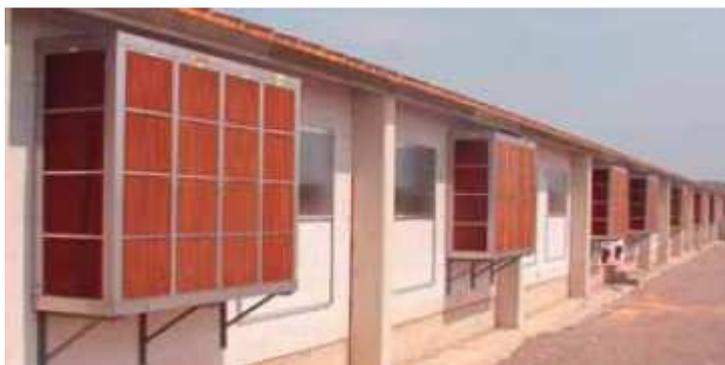
**Imagen 59. Panel evaporativo tipo caseta sin ventilador incorporado.**
