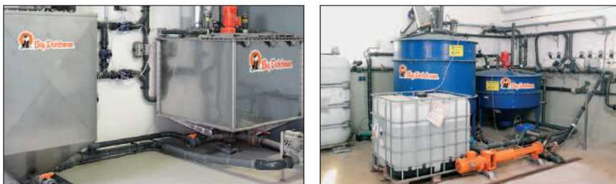
Imagen2. Tanques de mezclas de acero inoxidable y de plástico reforzado con fibra de vidrio.
